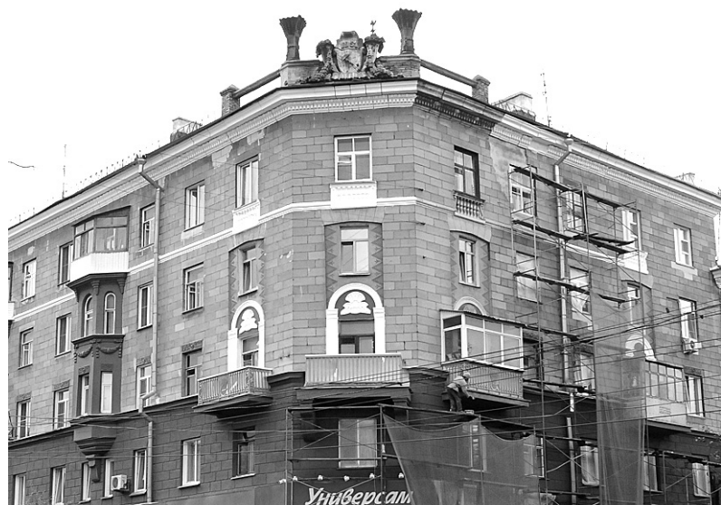
Капремонт дома № 2 по ул. Станиславского проводится ещё в рамках реализации 185-го ФЗ
